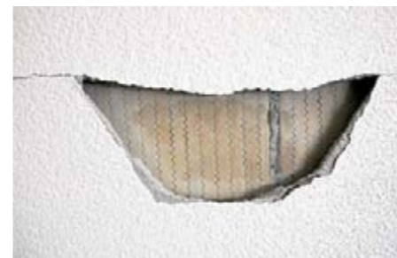
Der Untergrund wurde mit Wasser benetzt.
